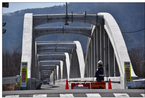
修繕工事が行われている昭和橋
