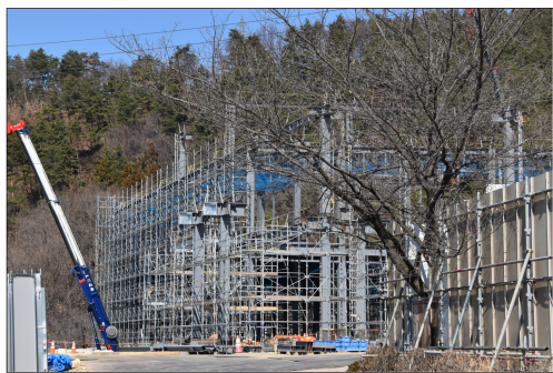
建設中の葛尾組合リサイクルセンター
