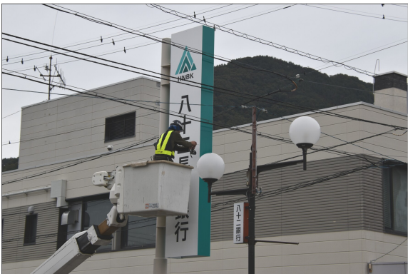
戸倉支店看板付け替え作業の様子（2025年10月）
