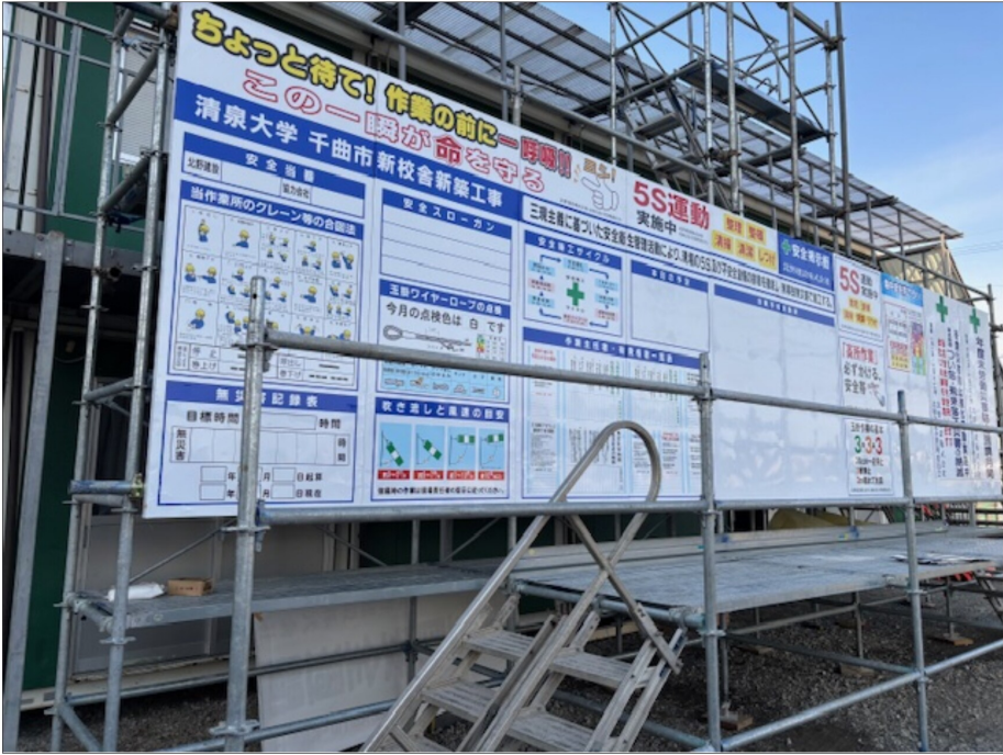
清泉大農学部新校舎建設の看板
