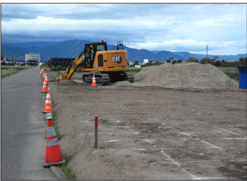
スマートICと接続する「重山2号線」の建設現場(白石千曲線合流付近)
