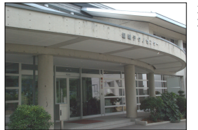
昨年改修工事が完了した坂城テクノセンター
