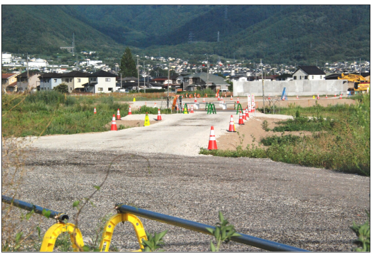
網掛地区改良工事(盛土工事: R8年1月末まで)
