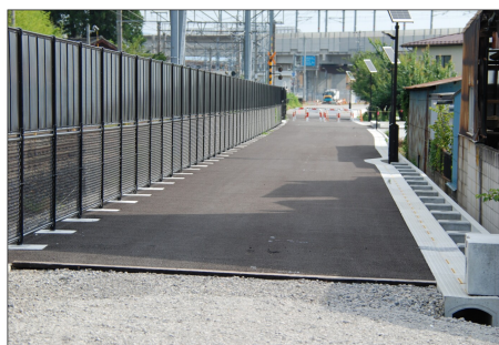
建設中の屋代線跡地・屋代工区 (市道屋代中学校北線・倉科踏切付近)
