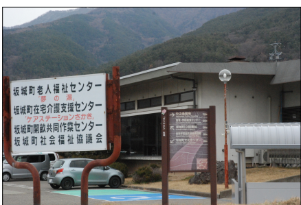
現在の坂城町老人福祉センター 昭和50年(1975)建築
