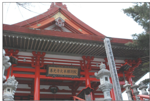
観音寺は今年1月より外壁などの修復工事を実施
