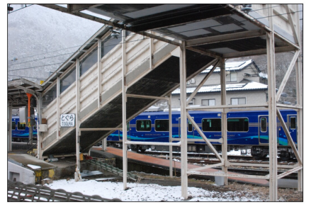
上りホーム側のエレベーターまでの通路には屋根が付けられる
